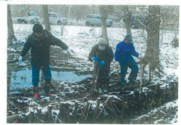
側溝の 杭打ち
